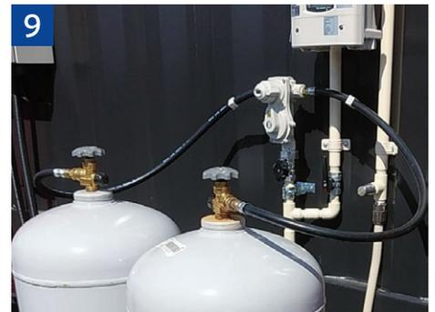
9 ガスボンベがトレーラーハウスに積載されているか、またはレンチのみで簡易に着脱できること。
