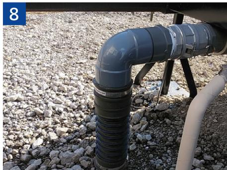
8 排水管の接続方法が工具無しで着脱できる方式であること。
