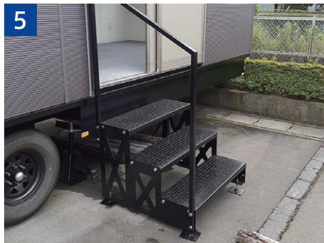
5 階段やデッキが独立した構造体であり、トレーラーハウスの移動に支障がない規模・構造であること。
