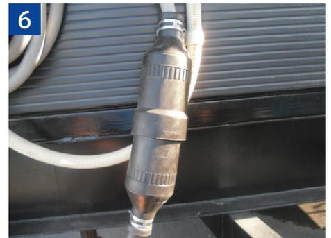
6 電気配線の接続方法が工具無しで着脱できる方式であること。
