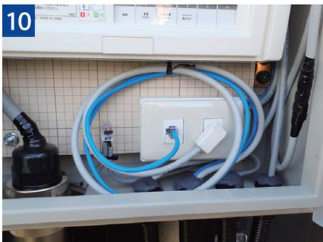
10 通信回線の接続方法が工具無しで着脱できる方式であること。
